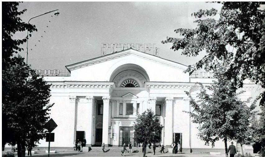
Рис. 3. Одно из зданий, построенное под руководством Л. П. Петрова
