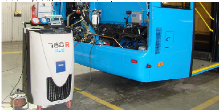
Рис. 8. Установка для заправки кондиционера хладагентом
